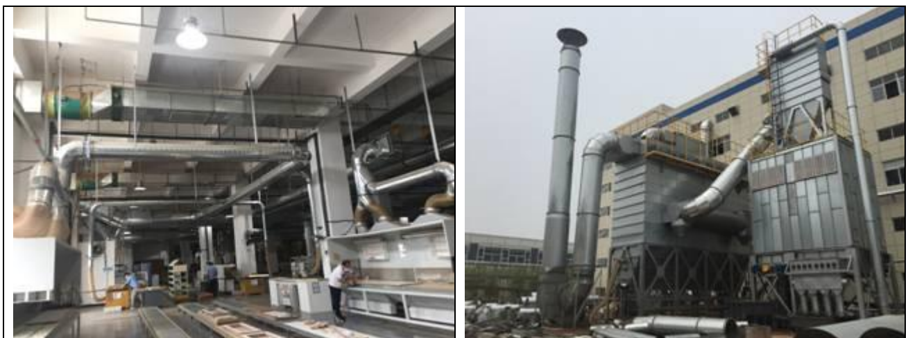
图 6.2-2 开料、砂光粉尘收集、处理措施图
